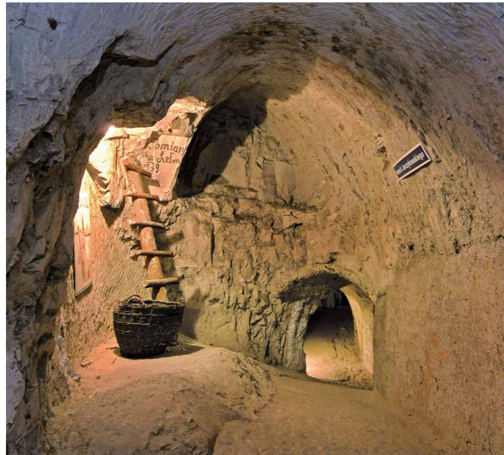
Podziemia kredowe w Chełmie, fot. K. Dromlewski The underground Chalk Tunnels in Chełm, photo by K. Dromlewski / Kreidegewölbe in Chełm, Fot. K. Dromlewski / Меловые подземелья в г. Хелм, фот. К. Дромлевски
