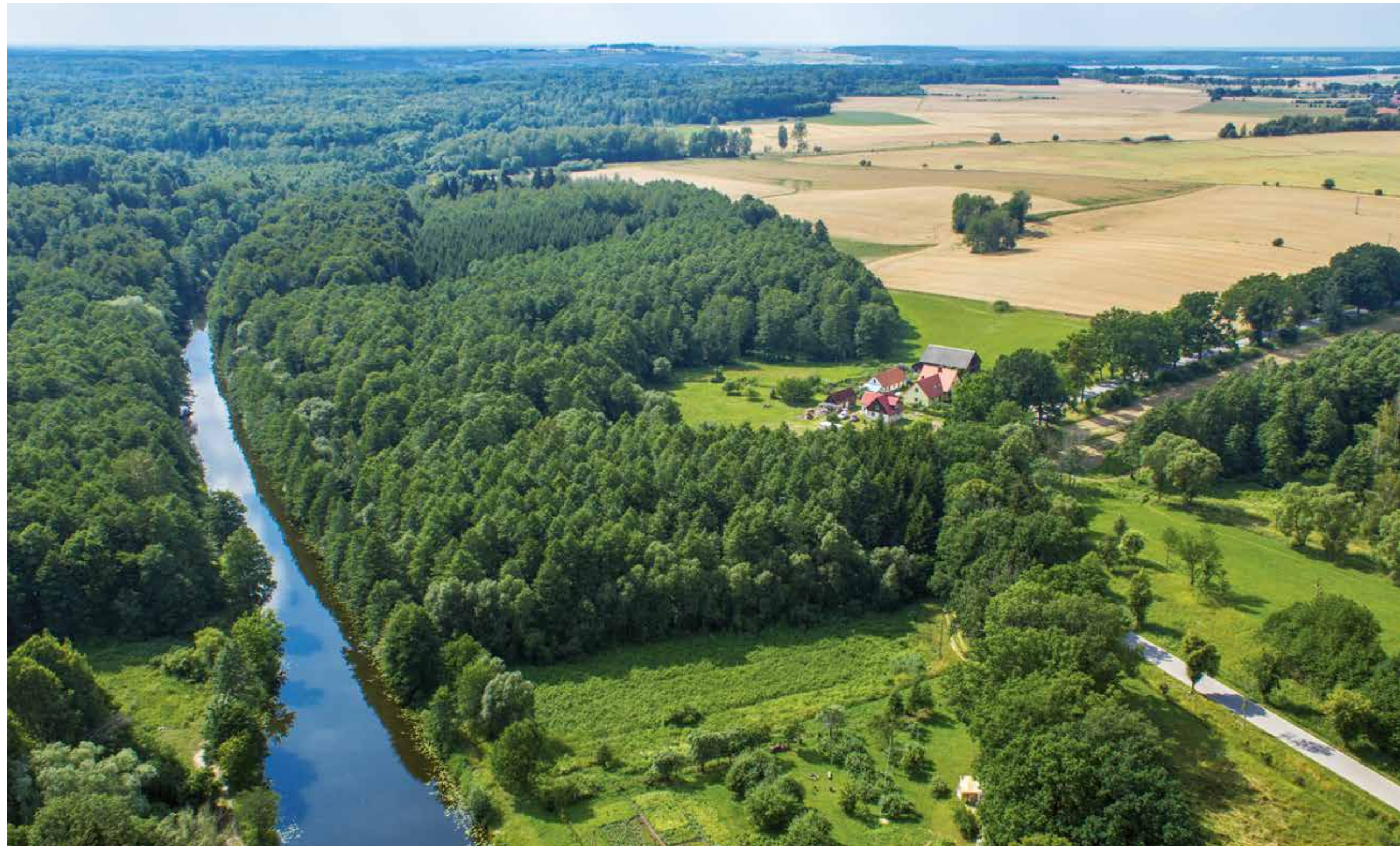
Kanał Mazurski, fot. M. Achtel Masurian Canal, photo by M. Achtel / Masurischer Kanal, Fot. M. Achtel / Мазурский канал, фот. М. Ахтель
