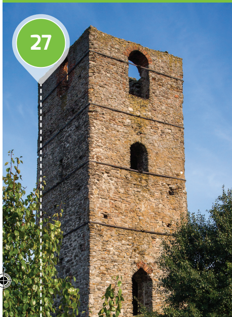
Średniowieczna wieża mieszkalno-obronna w Stołpiu
